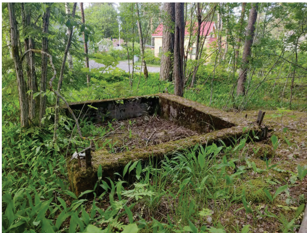
Kuva 10 Vanhan rakennuksen sokkeli Mattilantien varren metsikössä. kesäkuu 2021
